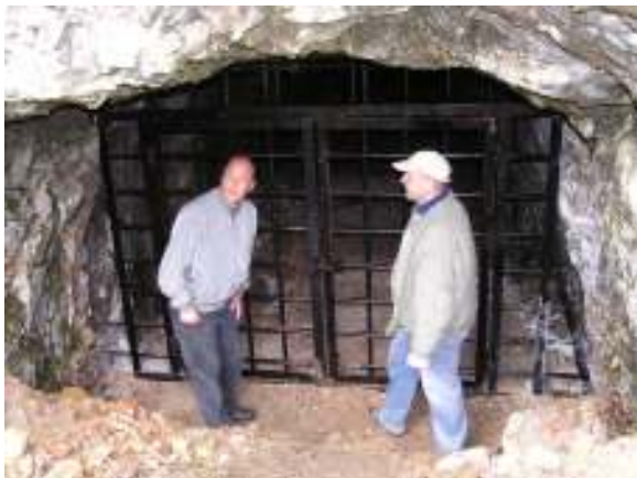
Verschiedene Beispiele von Stollensicherungen
