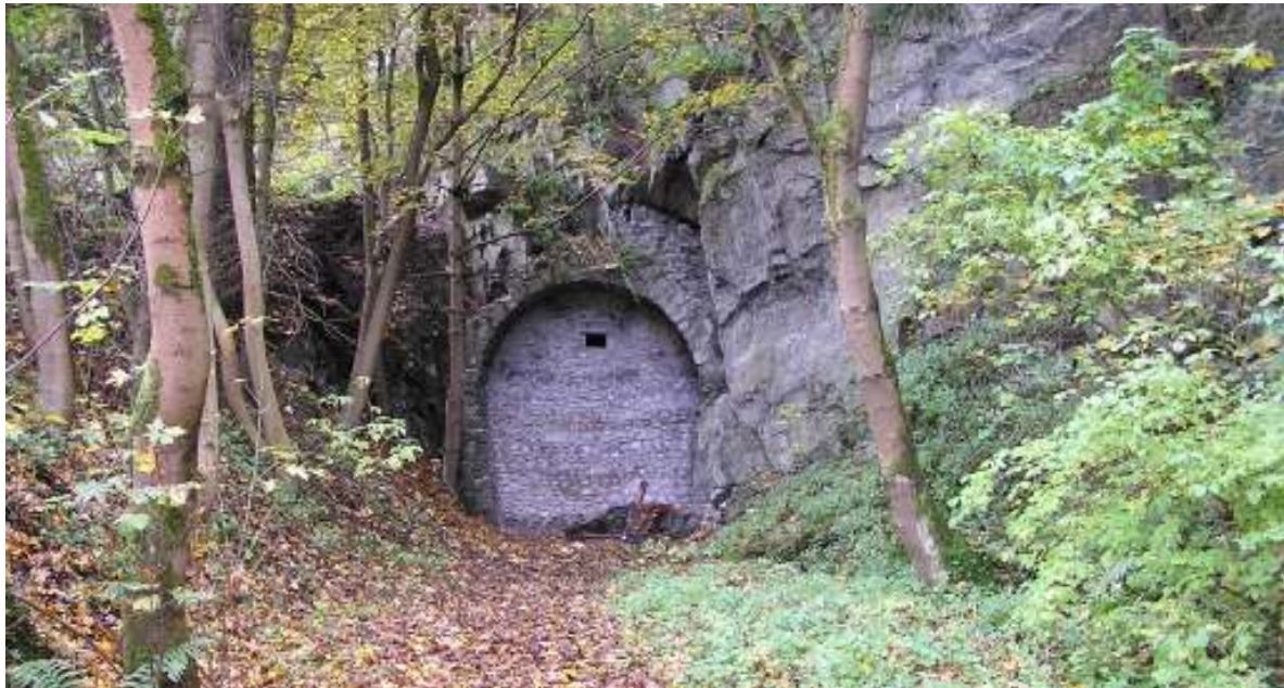
Tunnelsicherung bei Rübeland/Harz
