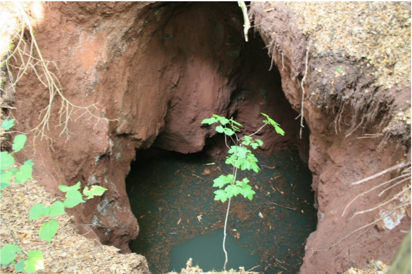
Abb. 3: Wasserstand am 24.09.2010 im Erdfall
