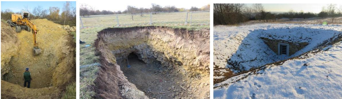
Abb. 3 bis 5 Öffnung und Sicherung eines Stollenverbruchs 2015
