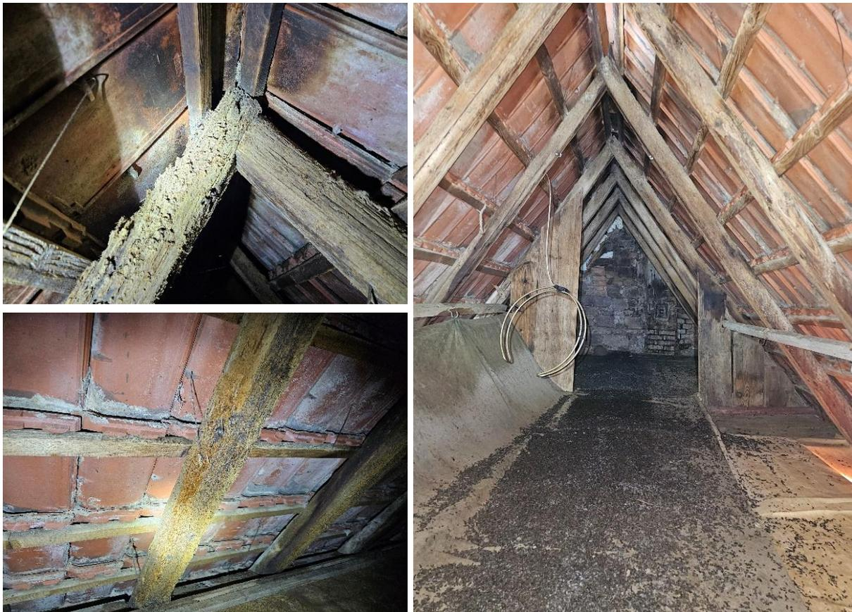
Abb. 8: Beschädigte Dachsparren und Blick in die Wärmeglocke oberhalb des Zwischenbodens
