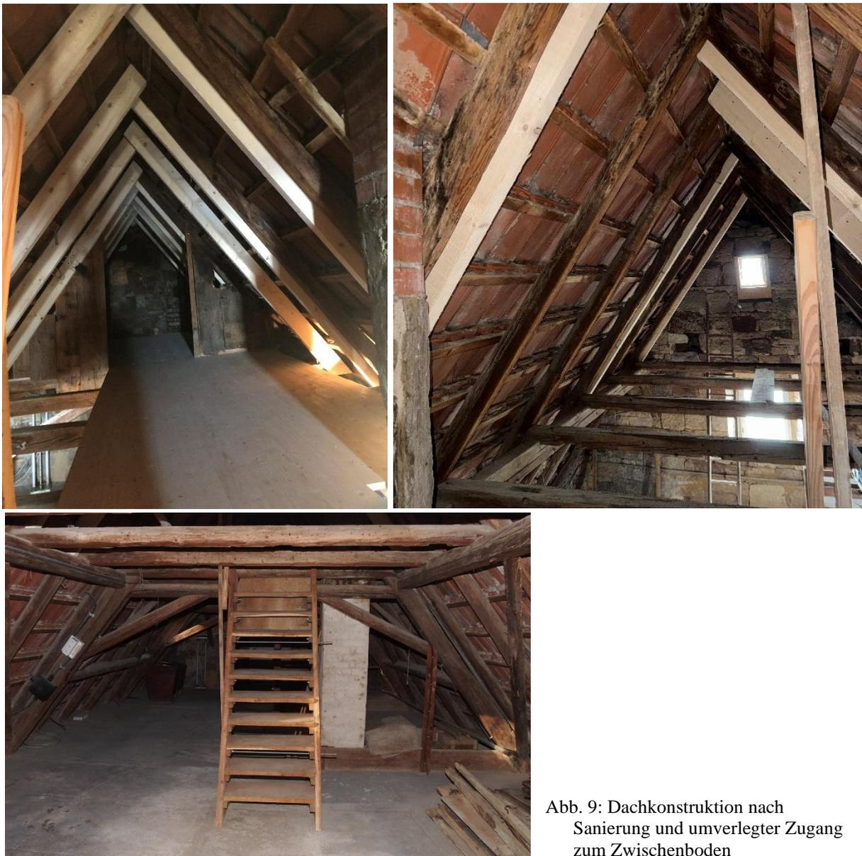
Abb. 9: Dachkonstruktion nach Sanierung und umverlegter Zugang zum Zwischenboden
